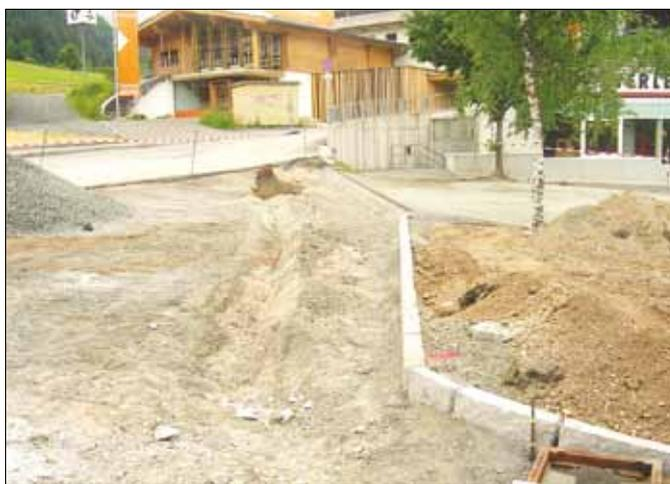
Im Bereich Bergbahnparkplatz wird die Zufahrt entwässert und asphaltiert sowie der Busumkehrplatz neu gestaltet.
